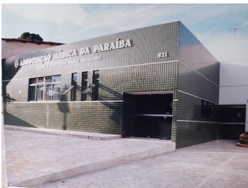
03 NOVA SEDE com finalizada reforma. inaugural.
