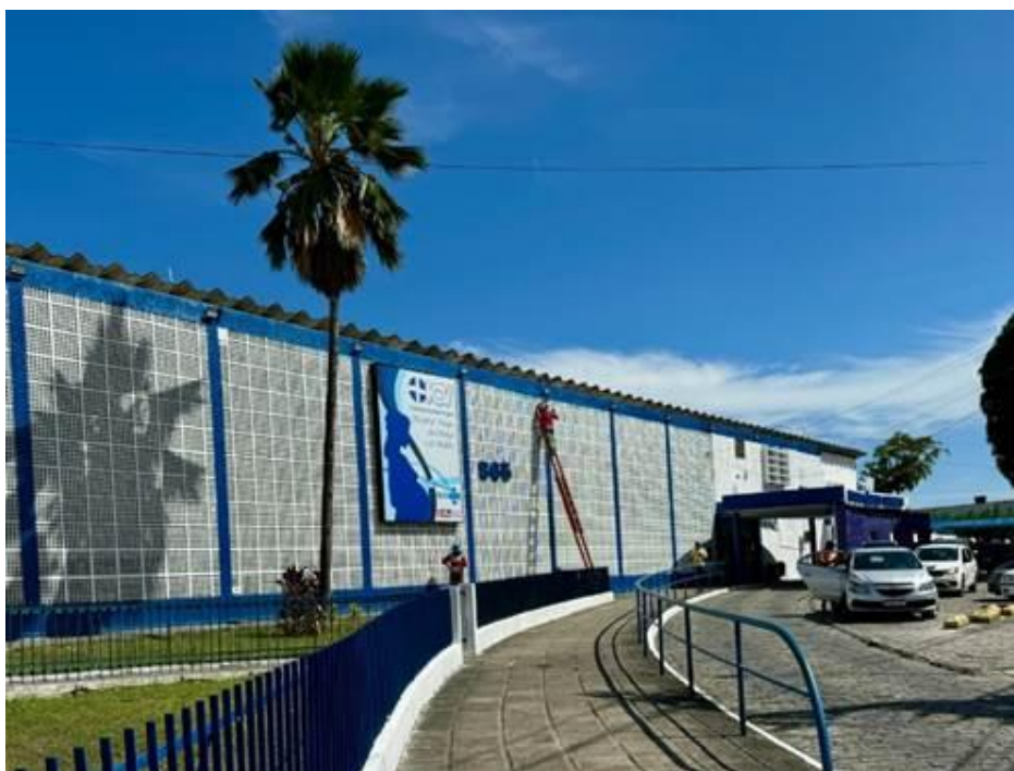
Figura 1 – A fachada da Maternidade Cândida Vargas
